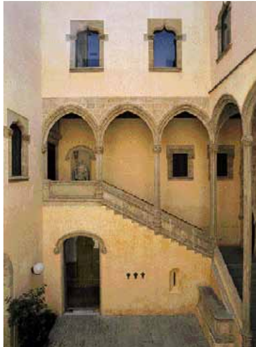
La façana oest incorpora l'escala principal de tipologia gòtica. Són originals el segon tram i la naia amb les corresponents baranes.
